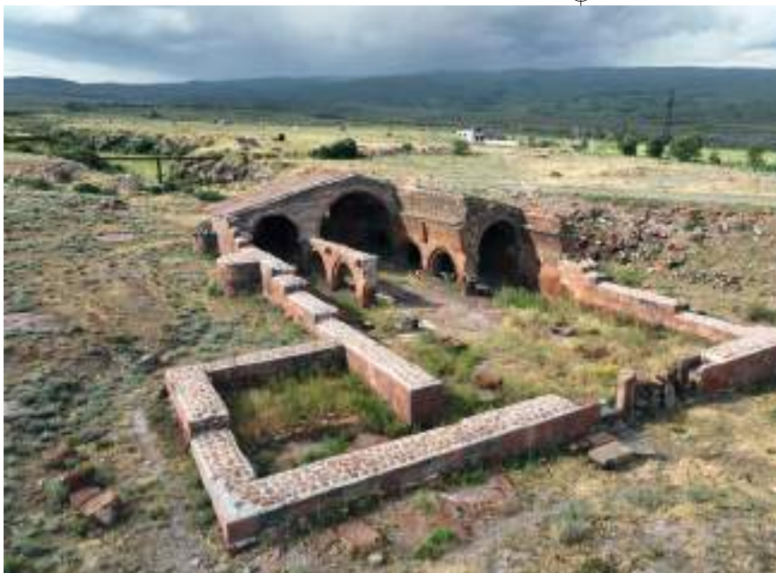
Il caravanserraglio di Aruch Արուճի քարավանատունը
